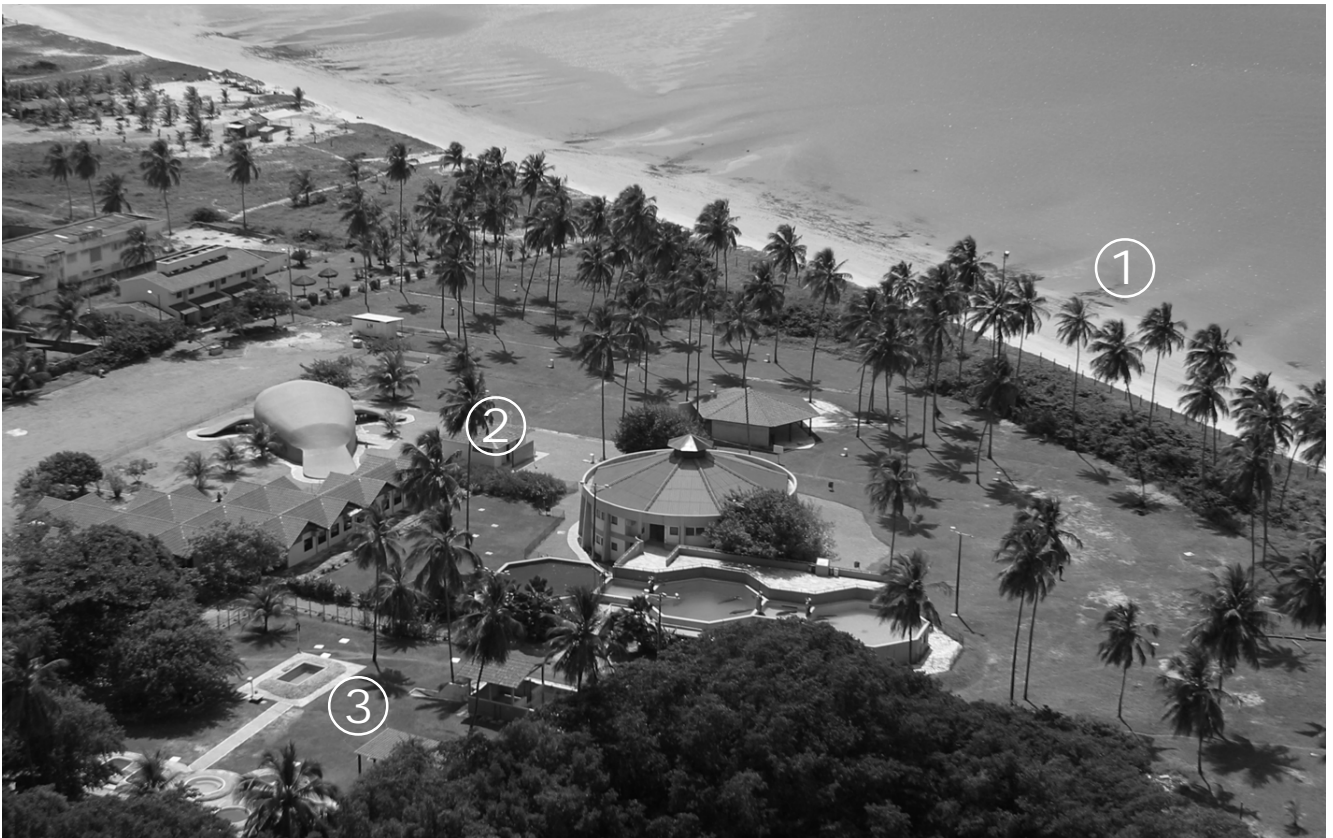
FIGURA 1: Local de captação de água para abastecimento das piscinas (1); piscinas de manutenção permanente (2); piscinas de reabilitação (3). Fonte: Falcão, G/FMA.
